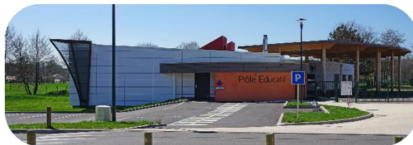
Pôle éducatif du Mont de Vannes
