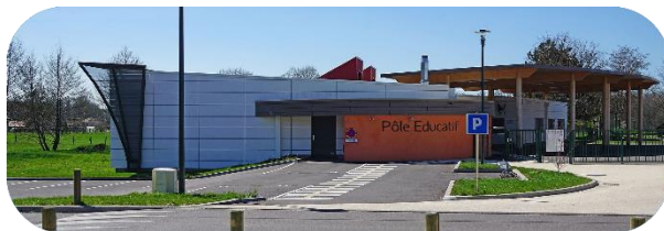
Pôle éducatif du Mont de Vannes
